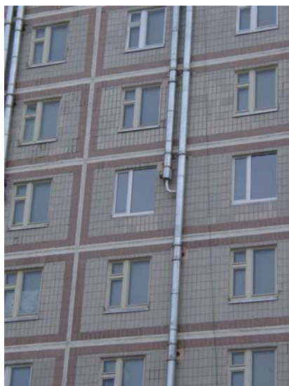
рис. 7а Коаксиальный воздухозабор и дымоудаление
