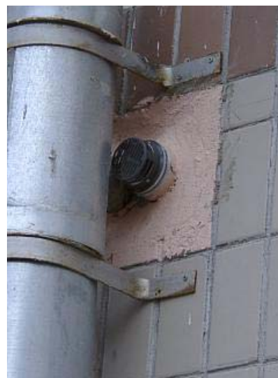
рис. 7а Коаксиальный воздухозабор и дымоудаление
