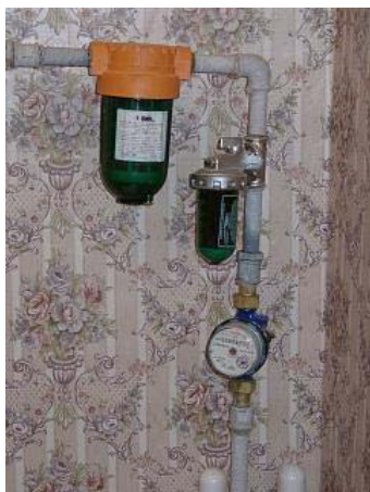
Рис 9. Узел подготовки и учета воды
